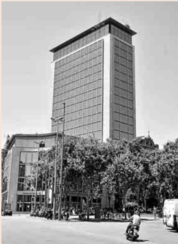
Edificio Deutsche Bank, en la Diagonal con el Passeig de Gràcia.
